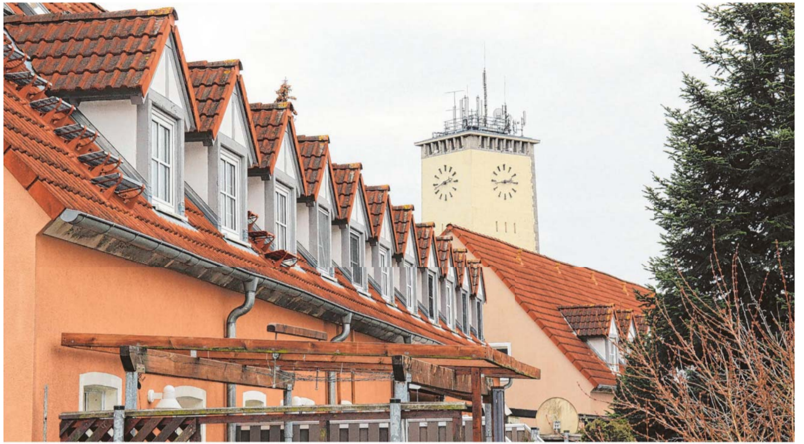
Die Schwarzhfelder Wasserturmsiedlung bildet den Kern der historisch gewachsenen Wandelhofsiedlung.
